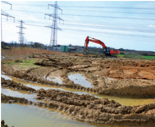
Fahrspuren mit dem Radlader, Gewässer mit dem Bagger.
