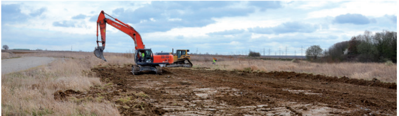
Abziehen der Pflanzendecke samt Wurzeln mit dem Bagger.
