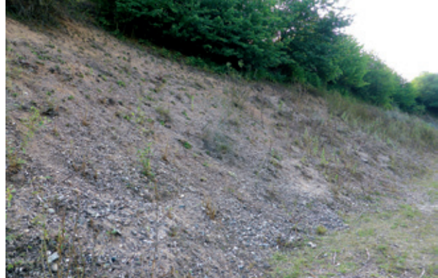
Winterquartier: Böschung nach der Entfernung des Aufwuchses.
