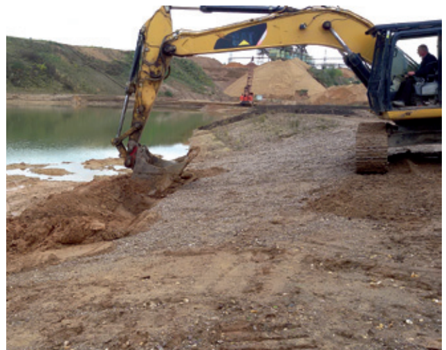
Anlage eines Flachwasserbereichs vom Ufer aus.
