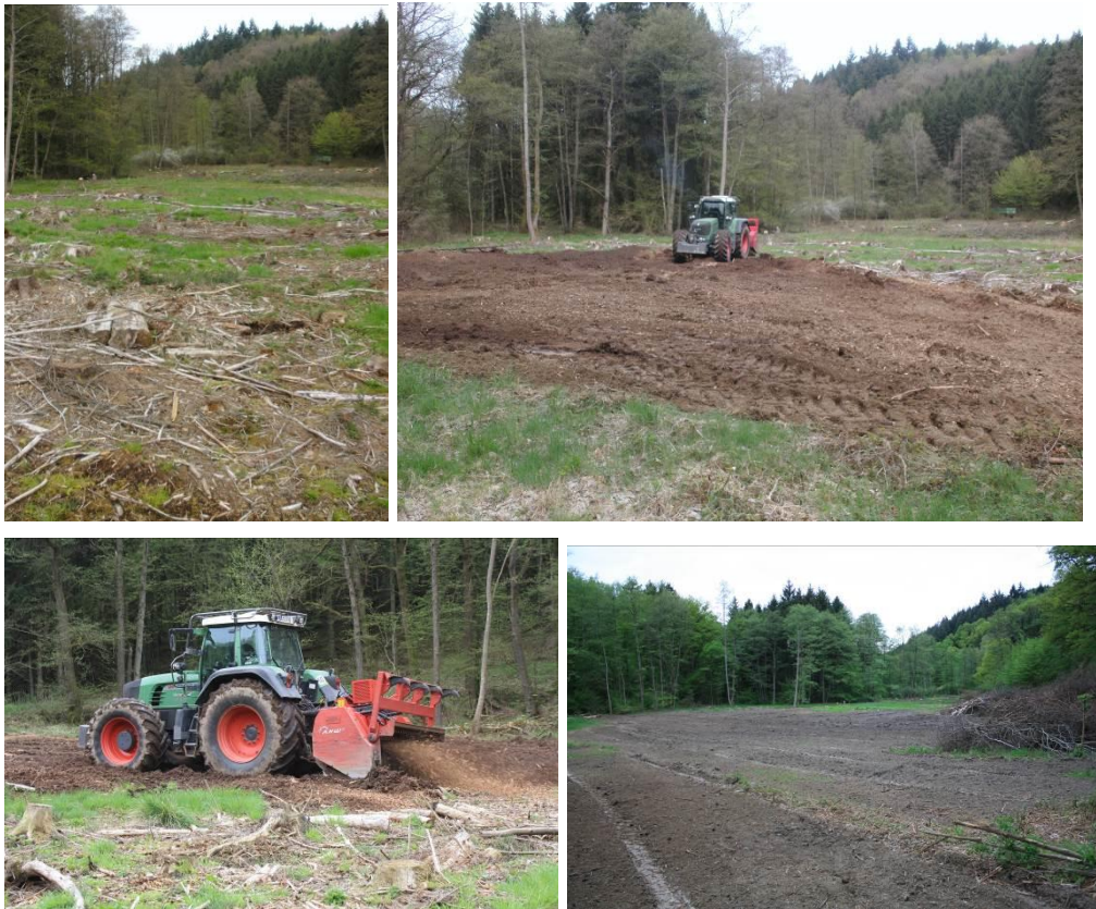
Abb. Zustand vor, während und nach Einsatz des Forstmulchers
